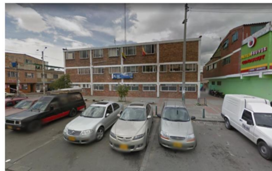
Ilustración 5 Costado oriental de la edificación.
