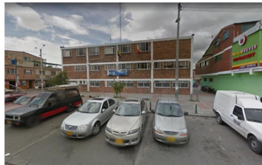
Ilustración 5 Costado oriental de la edificación.
