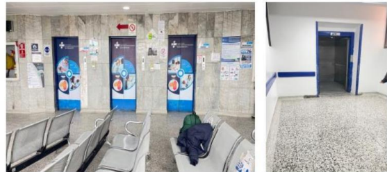
INSTALACION DE 4 EQUIPOS NUEVOS , 6 PARADAS
