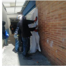
Cerramiento plazoleta unidad renal
