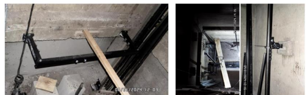
Se instalan soportes y rieles guía en foso ascensor No. 4
