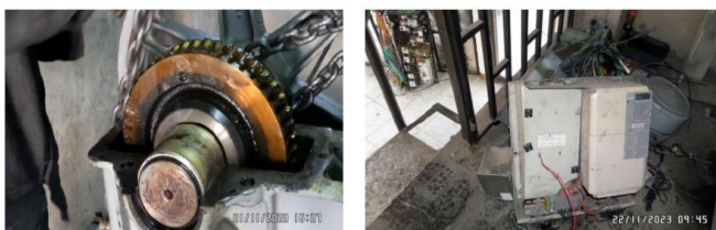
Desmantelamiento de máquina de ascensor No. 4
