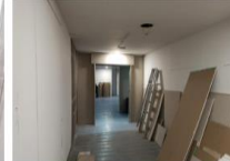
Adecuación de zona de campamentos de obra.
