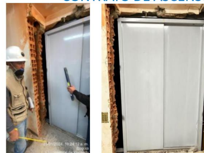
Instalación de soportes y rieles guía sección superior ascensor No. 1 y No.4
