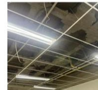
Desmonte de superboard cielo raso angiografo
