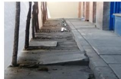
Adecuación de senderos para accesos de personal del hospital.
