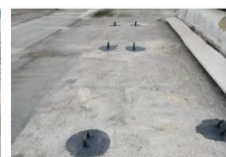
Instalación de anclajes para mantenimiento y de fachadas.
