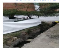
Excavación de viga para instalación de cerramiento
