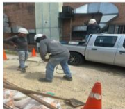
Extracción de muestras de suelo para ensayos zona plazoleta de acceso almacén
