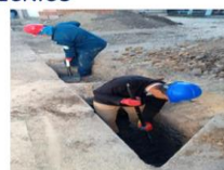
Excavación de viga para instalación de cerramiento
