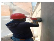
Actividades de demolición para instalación de portón de comunicación plazoleta urgencias y plazoleta unidad renal.
