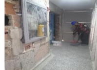
Demolición de mampostería y ampliación de vanos de ascensores.
