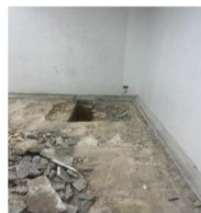
Demolición de piso angiografo.
