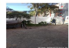
Desmonte de cerramiento exterior.
