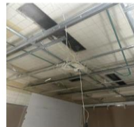
Desmonte de estructura de cielo raso angiografo.
