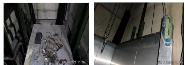
Desmantelamiento de cabina de ascensor No. 4
