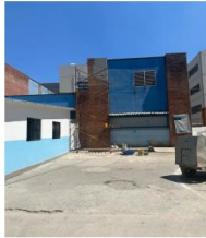
Actividades de mantenimiento de fachadas
