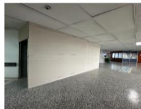
Cerramiento de ascensores zona salas de espera de piso 1 a piso 6
