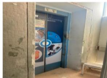
Demolición de vanos de ascensores de carga- ampliación de vanos.
