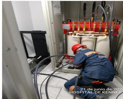
ACOMETIDAS ELECTRICAS SUBESTACIÓN- CUARTO ELECTRICO - ANGIOGRAFO
