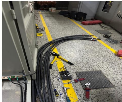
ACOMETIDAS ELECTRICAS SUBESTACIÓN- CUARTO ELECTRICO - ANGIOGRAFO
