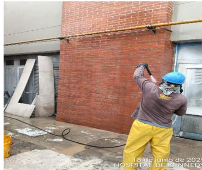
Actividades de mantenimiento fachada UTAC
