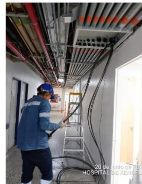
ACOMETIDAS ELECTRICAS SUBESTACIÓN- CUARTO ELECTRICO - ANGIOGRAFO
