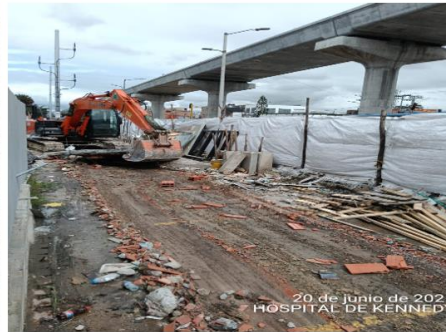
Retiro materiales especiales desmantelamiento
